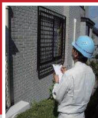
塗料メーカーが外装チェック
